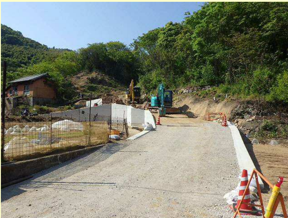
工事用道路工(R2.4月末時点)
