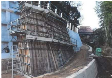
県急傾斜事業 下為角4111地区 (広島市安芸区)
