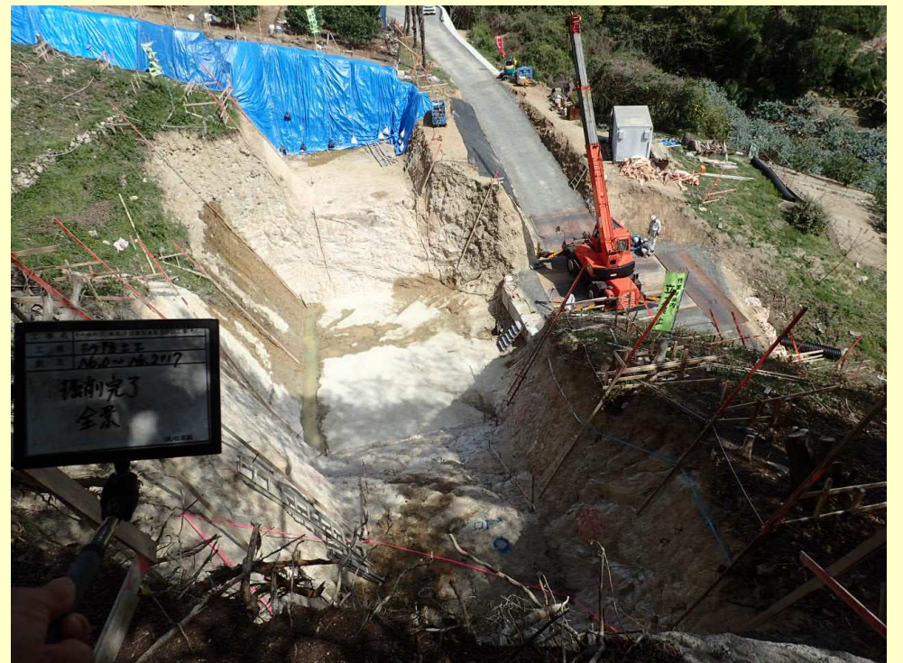
掘削工 (R3.3月末時点)
