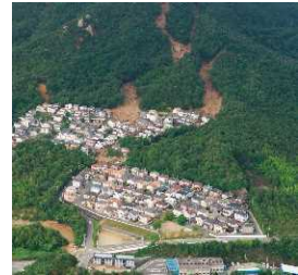
【平成30年7月豪雨の被災例】
