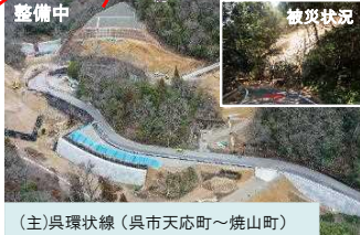
(主)呉環状線(呉市天応町～焼山町)
