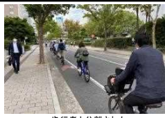
歩行者と分離された自転車通行空間(広島市)
