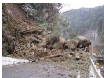
国道186号(北広島町細見(H29.1))
