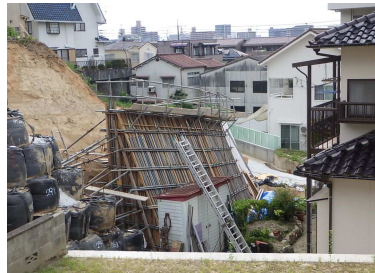
県急傾斜事業 南幸町13地区 (海田町南幸町)
