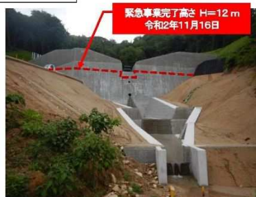
緊急事業完了高さ H=12m 令和2年11月16日
