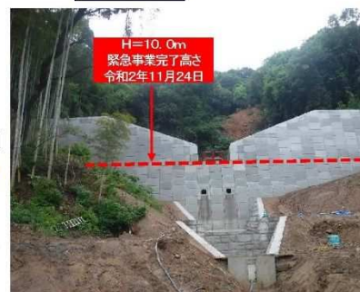
緊急事業完了高さ H=10.0m 令和2年11月24日
