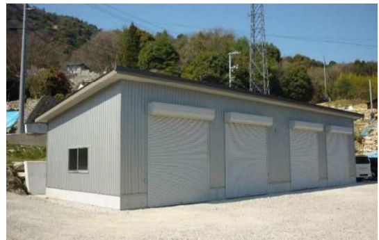
農業用倉庫の復旧状況（呉市）
