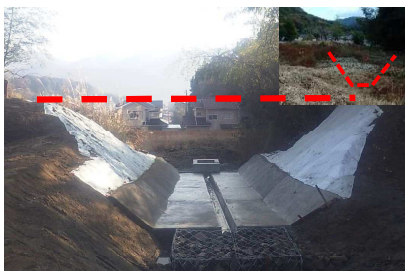
ため池の廃止工事状況（竹原市）
