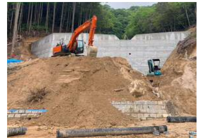
県治山激特事業 ワラヒノ山地区 (呉市郷原町)
