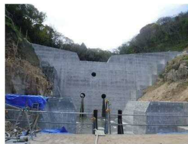
工事完了（令和3年5月7日）
