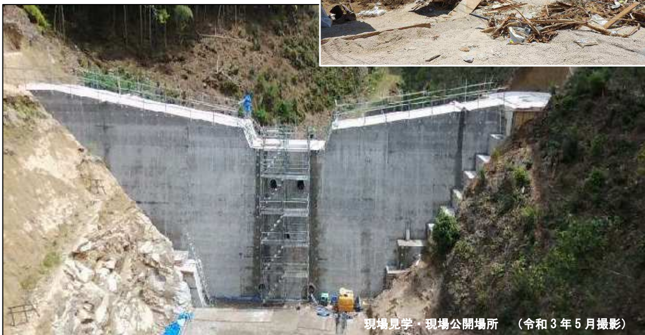
【天地川支川8 工事現場施工状況】
