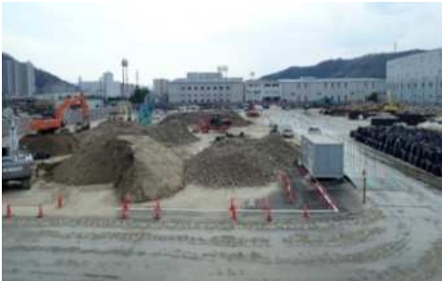
二次仮置場（坂町）処理中
