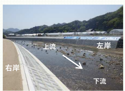
一級河川太田川水系 三篠川 災害復旧助成事業 (広島市安佐北区白木町地内)
