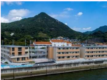
写真提供：大和ハウス工業株式会社
