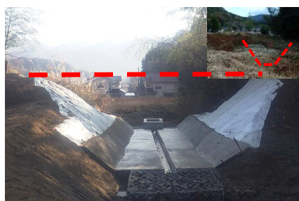
ため池の廃止工事状況（竹原市）
