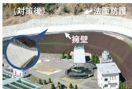
瀬野川浄水場（法面防護）
