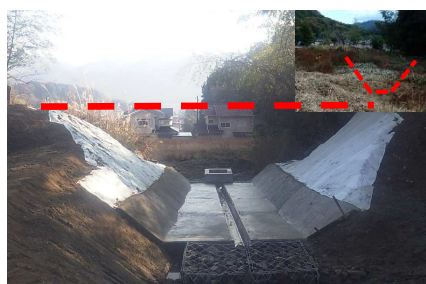
ため池の廃止工事状況（竹原市）
