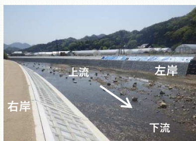
一級河川太田川水系 三篠川 災害復旧助成事業 (広島市安佐北区白木町地内)
