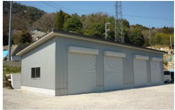
農業用倉庫の復旧状況（呉市）
