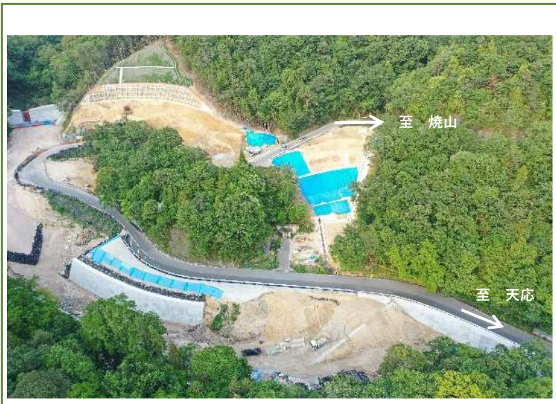
主要地方道 呉環状線 道路災害関連事業 (呉市天応町～焼山町地内)
