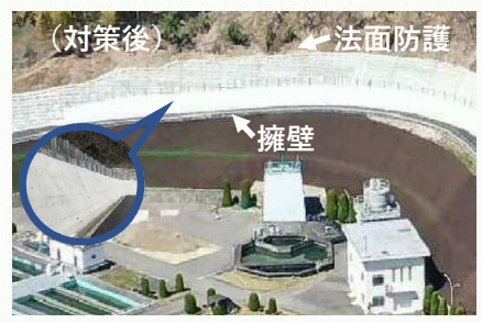
瀬野川浄水場（法面防護）
