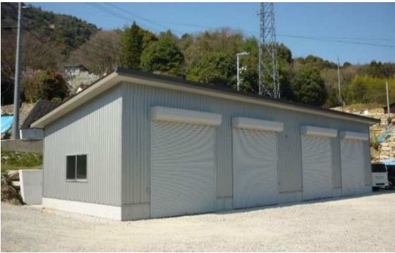
農業用倉庫の復旧状況 (呉市)
