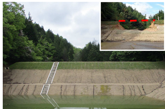
ため池の復旧工事状況 (北広島町)
