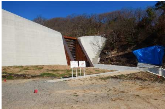
砂防指定地内河川 西福地川 災害関連緊急砂防事業 (三原市木原6丁目)
