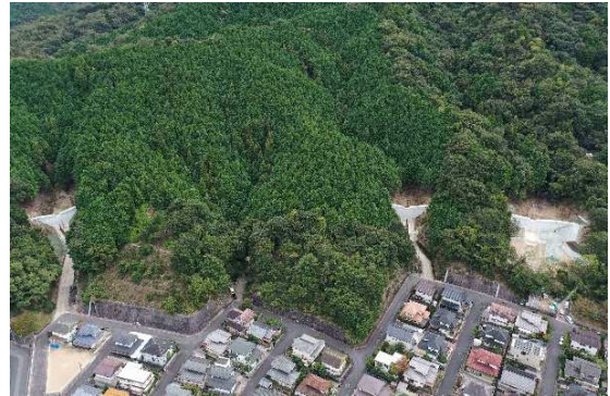
災害関連緊急治山事業 (広島市安佐北区)
