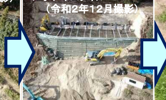
ジオテキスタイル工(令和2年12月撮影)
