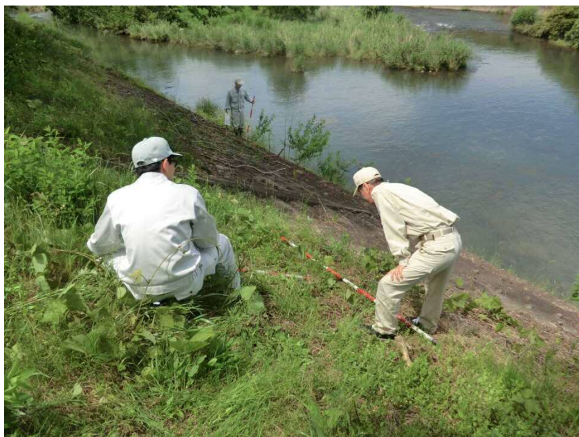
堤防点検の様子（馬洗川）
