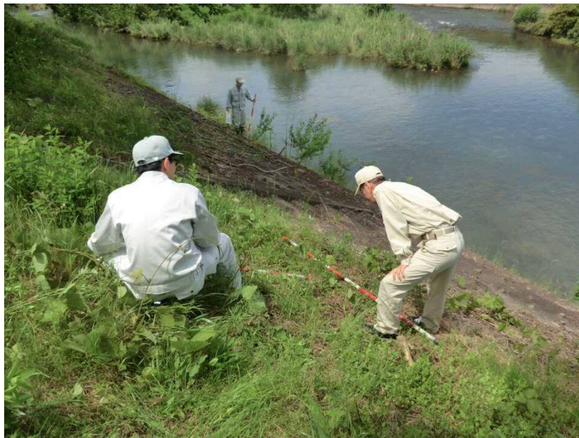
堤防点検の様子（馬洗川）
