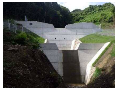
県治山激特事業 上山守(2)地区 (福山市駅家町)
