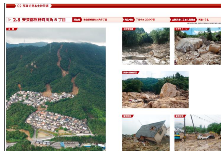
出典：平成30年7月豪雨災害（広島県土木建築局砂防課）
