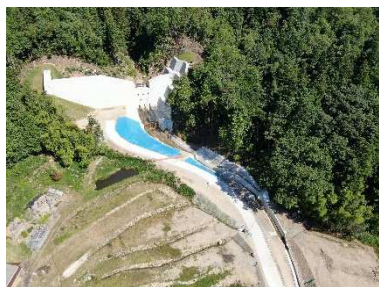
県砂防激特事業 杉坂下川隣 (東広島市志和町)
