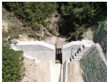
県砂防激特事業 天地川支川6 (坂町小屋浦)
