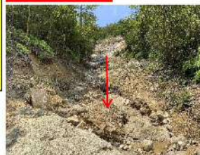
土砂流出状況
