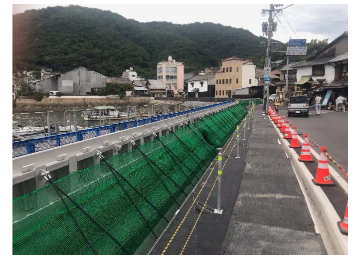
現在工事中のゲートも今回は起伏しました。
