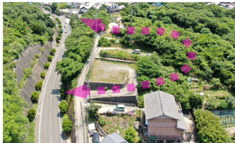
【工事着手前 R3.6.23】
