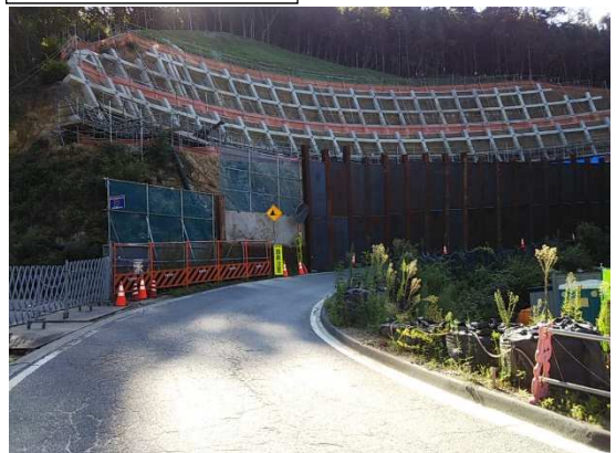
②法面工施工状況
