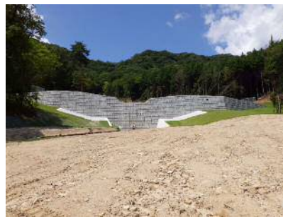
県：治山激甚災害対策特別緊急事業 前境地区 (東広島市西条町)
