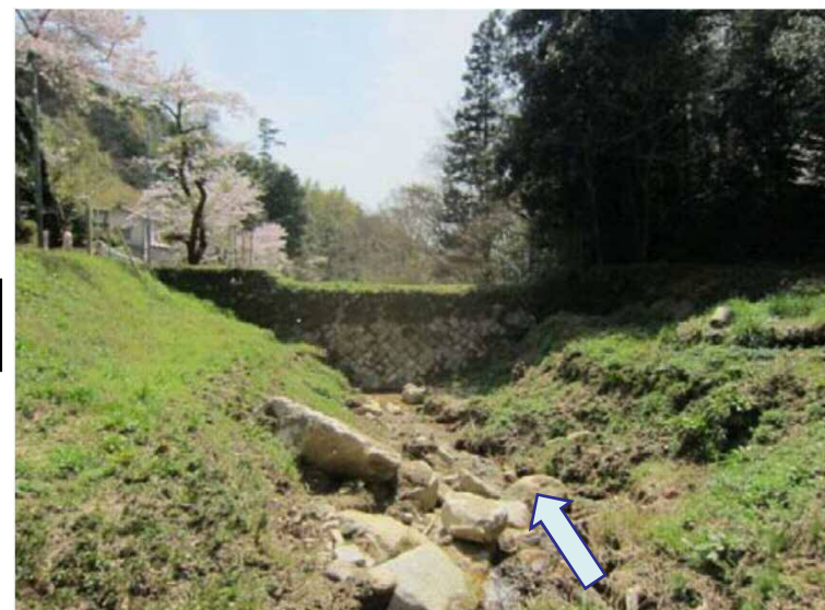
土石流発生前 の状況 (H28.9)
