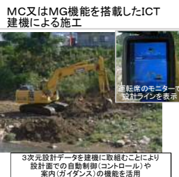
3次元設計データと3次元出来形測量の結果を重ねた管理を行う
