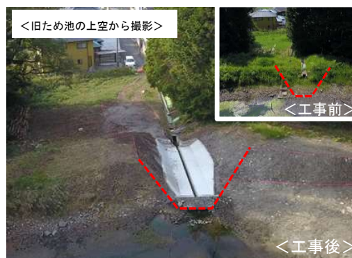
ため池の廃止工事状況（安芸高田市）
