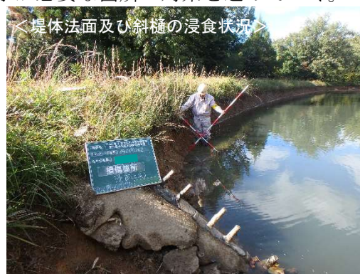
劣化診断の実施状況（東広島市）
