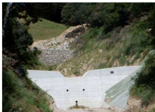
県：治山激甚災害対策特別緊急事業 カノオク山地区 (呉市安浦町)
