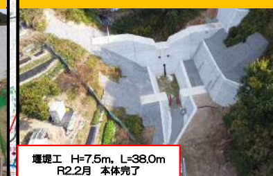
堰堤工 H=7.5m, L=38.0m R2.2月 本体完了
