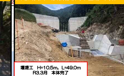
堰堤工 H=10.5m, L=49.0m R3.3月 本体完了
