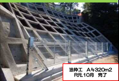
法枠工 A≒700m 2 R2.4月完了
