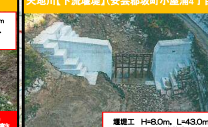
堰堤工 H=8.0m, L=43.0m R2.11月 本体完了
