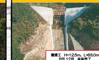
堰堤工 H=12.5m, L=63.0m R元.12月 本体完了
