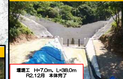
堰堤工 H=7.0m, L=38.0m R2.12月 本体完了
