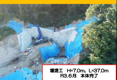
堰堤工 H=7.0m, L=37.0m R3.6月 本体完了
