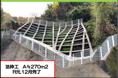
法枠工 A≒270m 2 R元.12月完了
