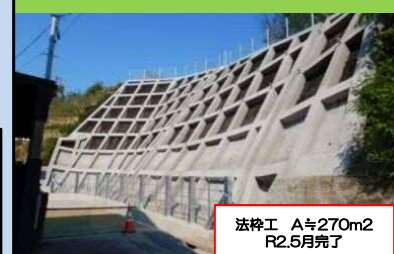
法枠工 A≒270m 2 R2.5月完了
