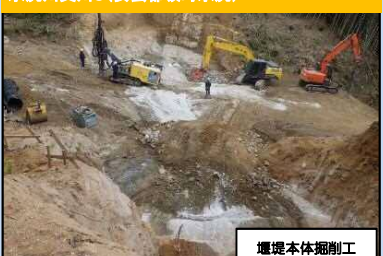
堰堤本体掘削工
