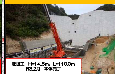
堰堤工 H=14.5m, L=110.0m R3.2月 本体完了
