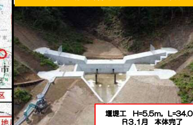
堰堤工 H=5.5m, L=34.0m R3.1月 本体完了
