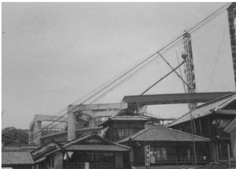
音戸側側橋梁の架設 ★
