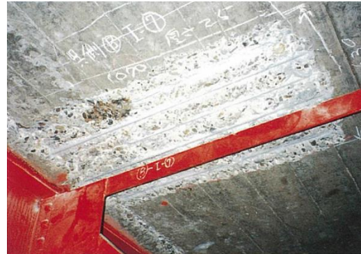
②鉄筋の防錆処理（錆止め）
