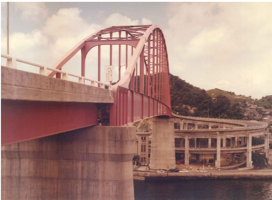
幅の異なる弦材と補剛桁の間も違和感なく取付いている
