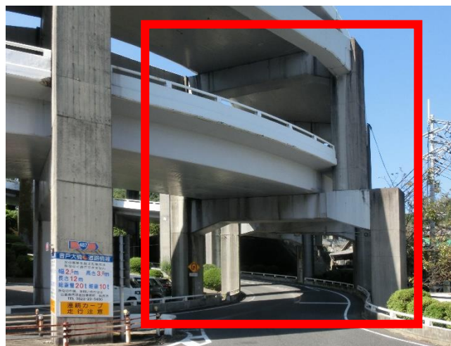
8号橋脚（赤枠内）
