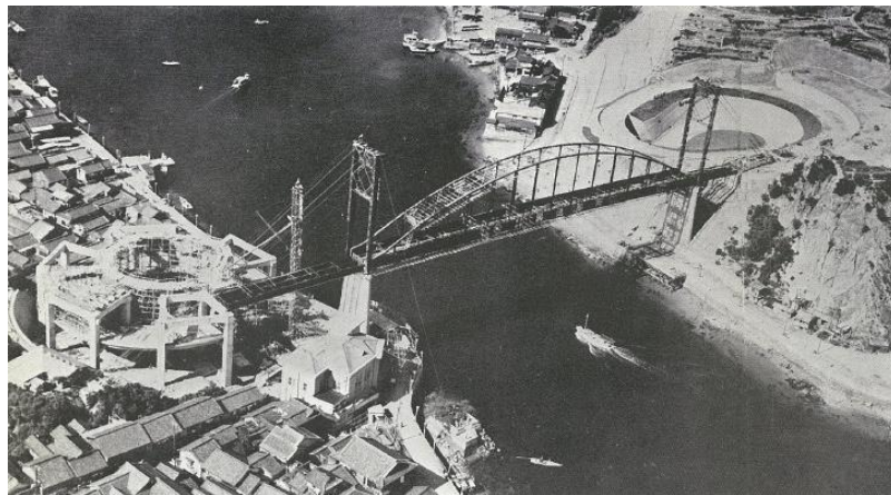
桁架設が完了した音戸大橋の主橋梁
