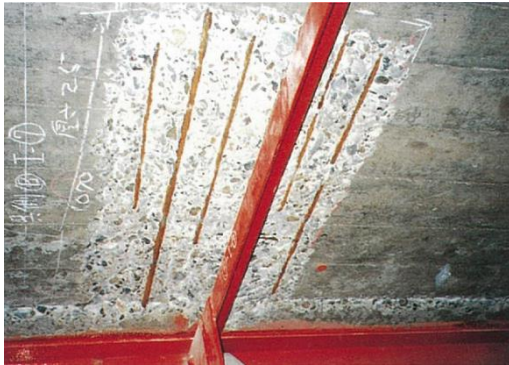
①不良箇所の除去（はつり）
