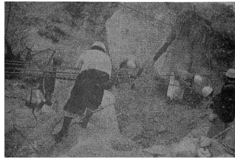
転石背後の根掘り・引き込み状況
