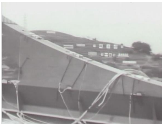
ひずみ計測機器設置状況
