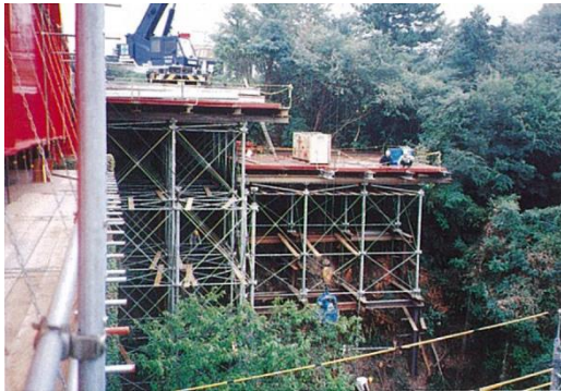
仮設ヤード施工中
