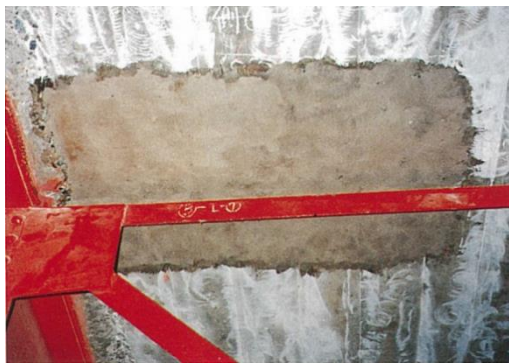
③断面修復完了
