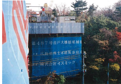
仮設ヤード完了
