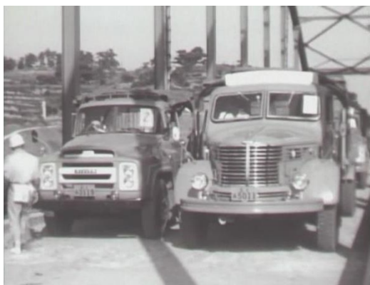
静的荷重試験（並列配置）
