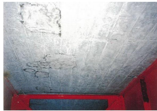
④ケレン作業完了
