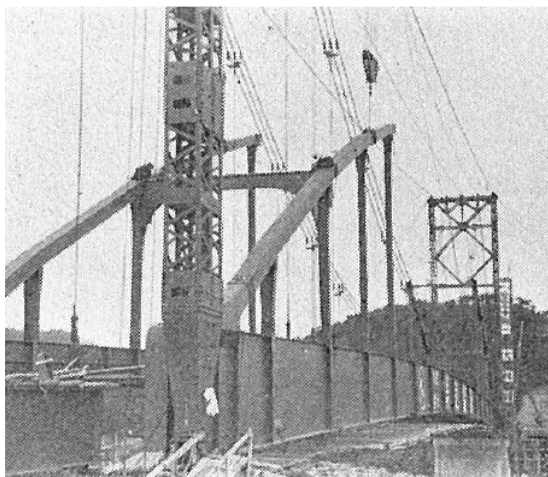
弦材（アーチ）の架設
