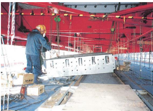
パネル設置状況
