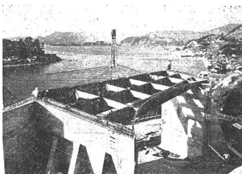
架設が進む主桁（外側突出桁取付前）
