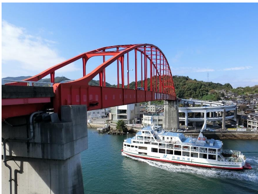
螺旋式高架橋により桁下高を確保した音戸大橋
