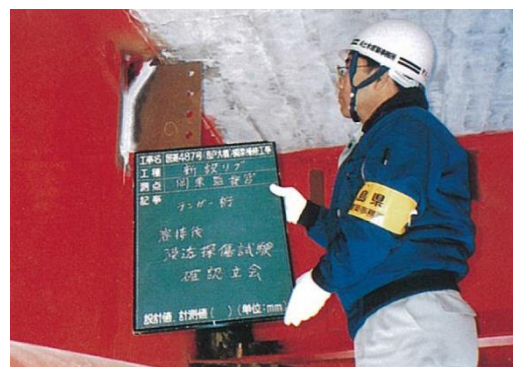
溶接探傷試験
