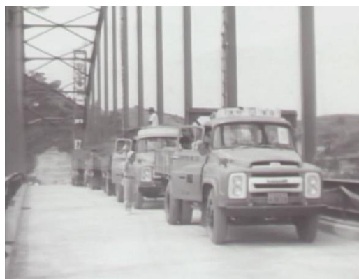
静的荷重試験（縦列配置）
