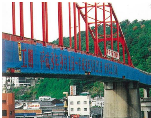
吊り足場の外観
