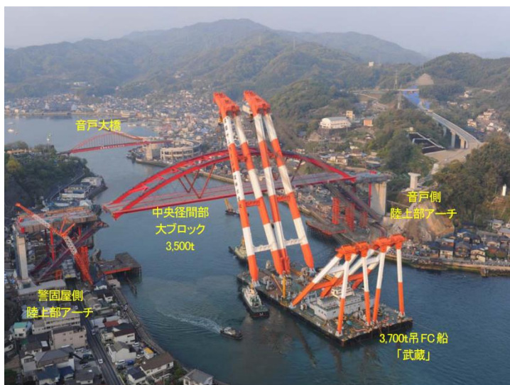
第二音戸大橋大ブロッカー一括架設
