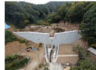
工事了（令和3年11月15日）
