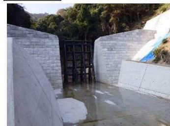
工事状況（令和3年11月19日）
