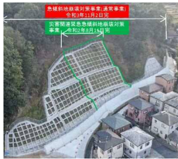
県：急傾斜地崩壊対策事業 下為角 4111 地区 (広島市安芸区)
