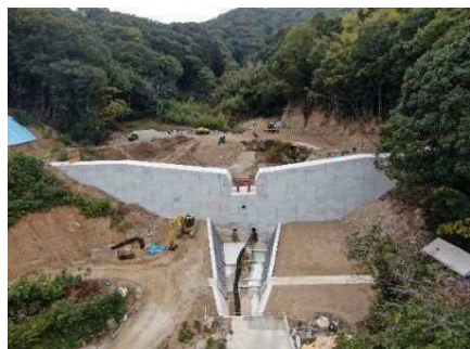
県：砂防激甚災害対策特別緊急事業 岡棟川 (呉市音戸町)
