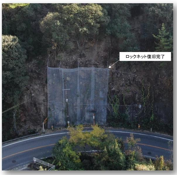
【第3段階】 夜間全面通行止(10月18日23時~22日5時)クレーンで資材搬入。 交通規制なし(10月23日~11月13日)落石発生源である岩をワイヤー等で固定。 夜間全面通行止(11月15日23時~20日5時)クレーンで資材搬出。
