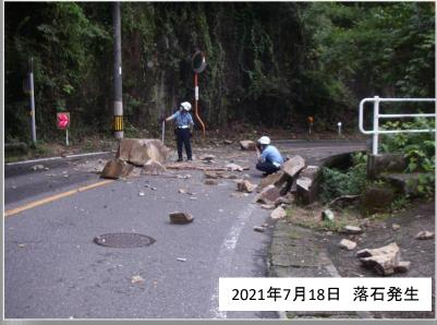
【第1段階】 全面通行止め(令和3年7月18~21日)浮石撤去・モルタル吹付・仮設防護柵設置 ⇒ 片側交互通行
