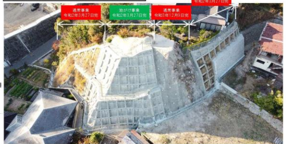
工事完了（令和3年12月9日）
