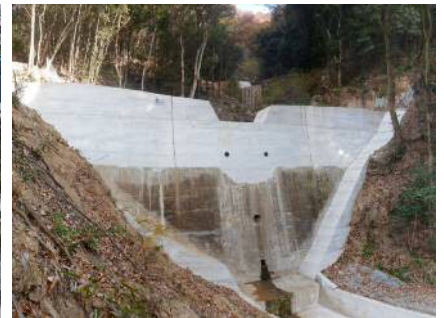
県：治山激甚災害対策特別緊急事業
