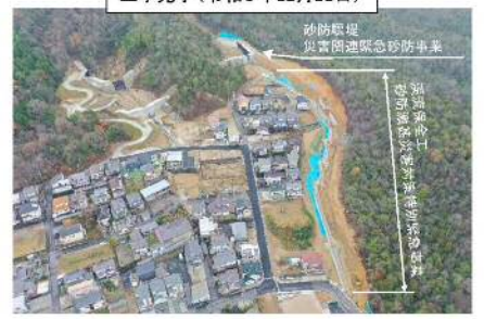
工事完了（令和3年12月21日）
