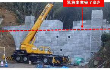
工事完了（令和3年12月17日）
