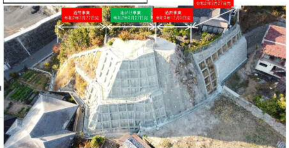
工事完了（令和3年12月9日）
