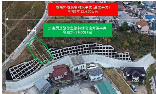
県：急傾斜地崩壊対策事業
