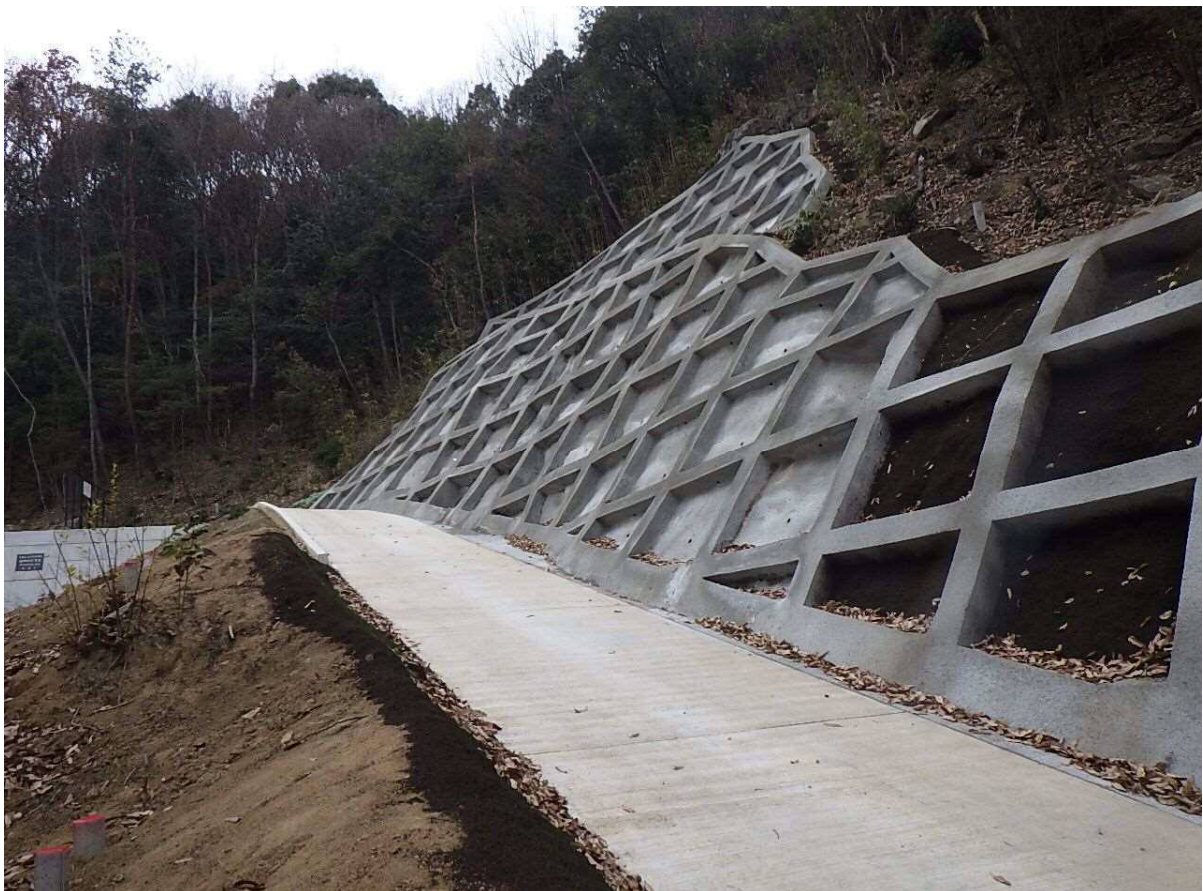
管理用道路工
