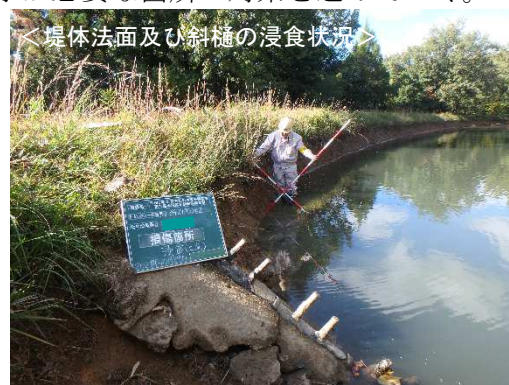
劣化診断の実施状況（東広島市）
