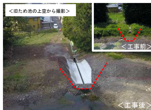
ため池の廃止工事状況（安芸高田市）
