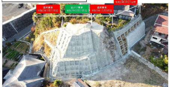
工事完了（令和3年12月9日）
