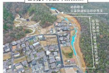
工事完了（令和3年12月21日）
