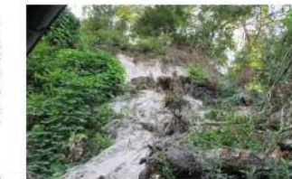
斜面崩壊・被災状況（H30年7月）
