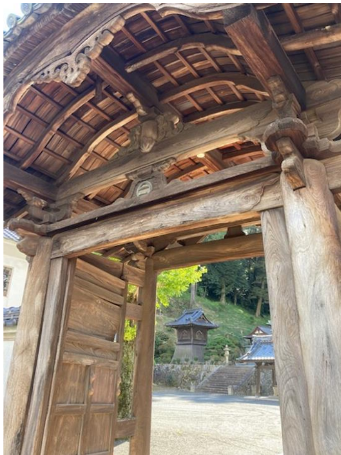
常国寺唐門 正面写真（参道側より）
