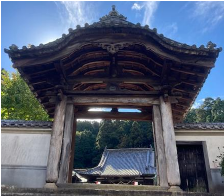
常国寺唐門 正面写真（参道側より）
