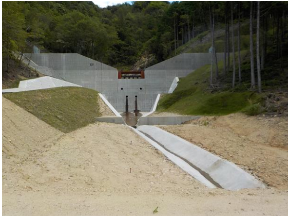
県：砂防激甚災害対策特別緊急事業 畑賀川支川7 (広島市安芸区)
