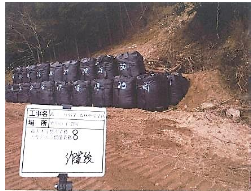
【 人工林被災箇所への大型土のう設置 】
