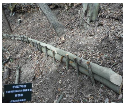
【土砂流亡防止用の丸太柵の設置】
