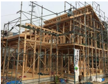
建設中の県産材住宅（広島市）
