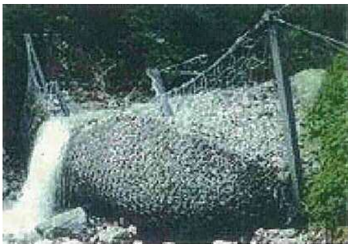
土石流捕捉状況
