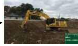
③ICT建設機械による施工
