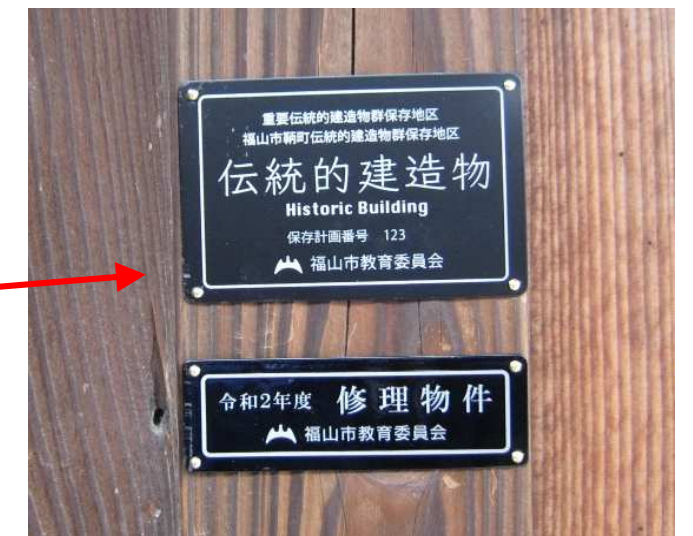
設置状況（拡大）
