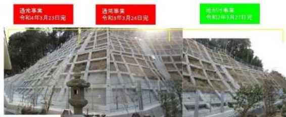
工事完了（令和4年3月23日）
