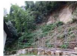
斜面崩壊・被災状況（H30年7月）
