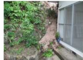
斜面崩壊・被災状況（H30年7月）
