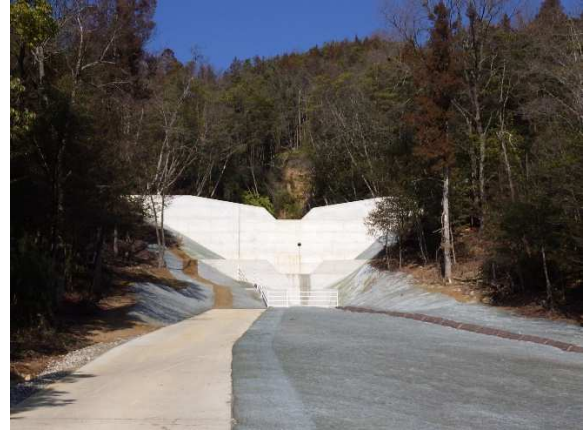
県：治山激甚災害対策特別緊急事業 吉川3地区 (東広島市八本松町)
