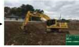
③ ICT建設機械による施工
