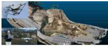
① UAV等による3次元測量
