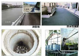
雨水貯留浸透施設の例
