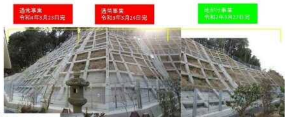
工事完了（令和4年3月23日）
