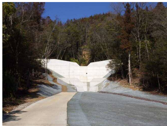
県：治山激甚災害対策特別緊急事業 吉川3地区 (東広島市八本松町)
