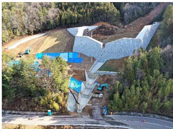
県：砂防激甚災害対策特別緊急事業 山岡西川隣 (三原市久井町)
