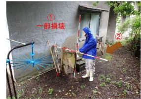
斜面崩壊・被災状況（R2年7月）
