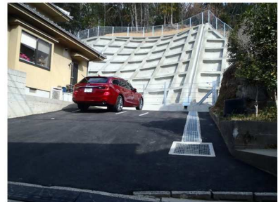
工事完了(令和4年2月22日)
