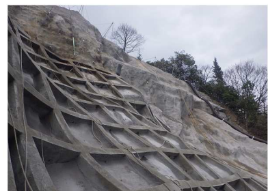
工事完了（令和4年3月31日）
